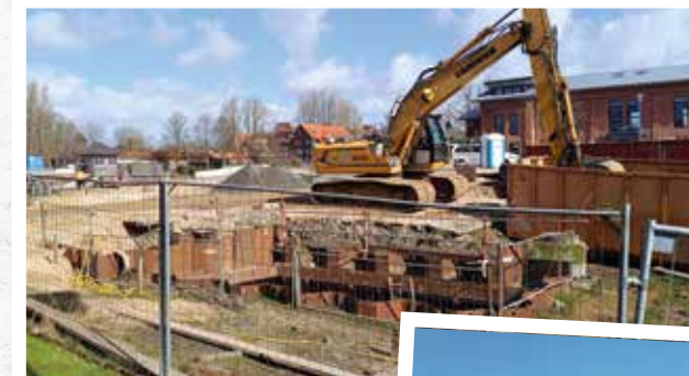
Vorarbeiten für den Anschluss der Versorgungsleitungen
