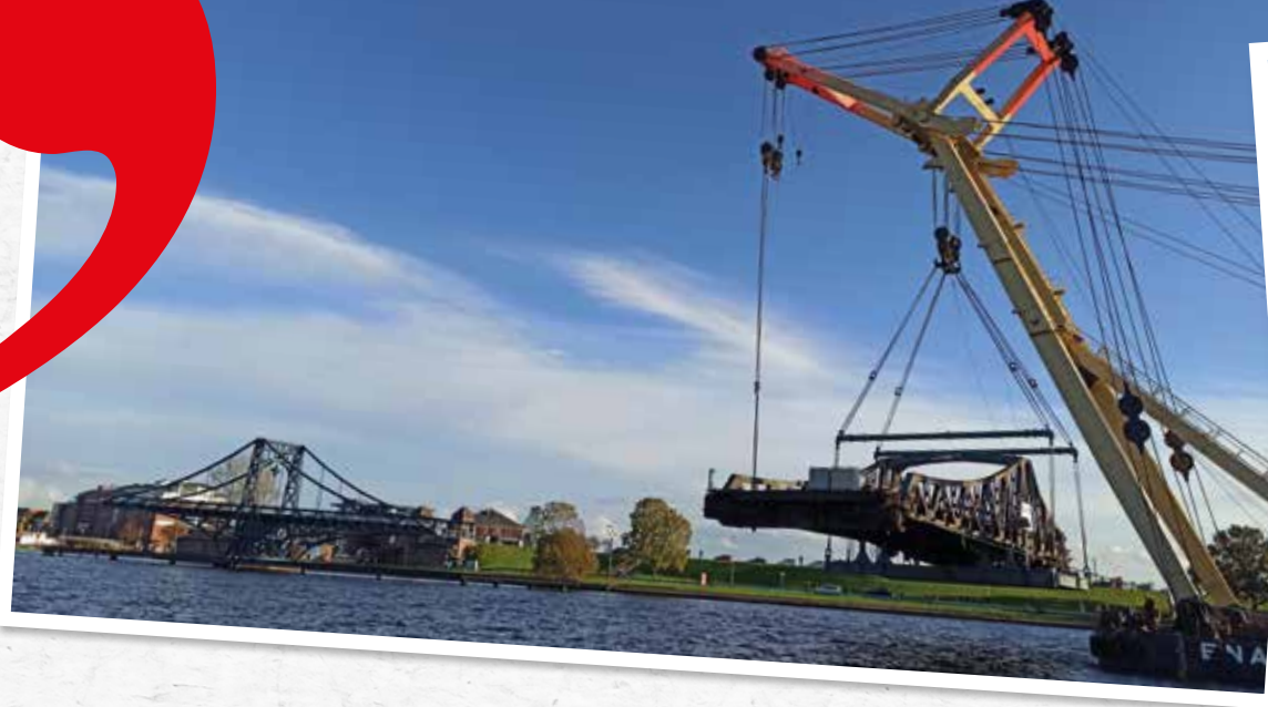
Der Schwimmkran mit der Deichbrücke am Haken
