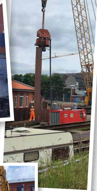
Rammarbeiten neben der Halle
