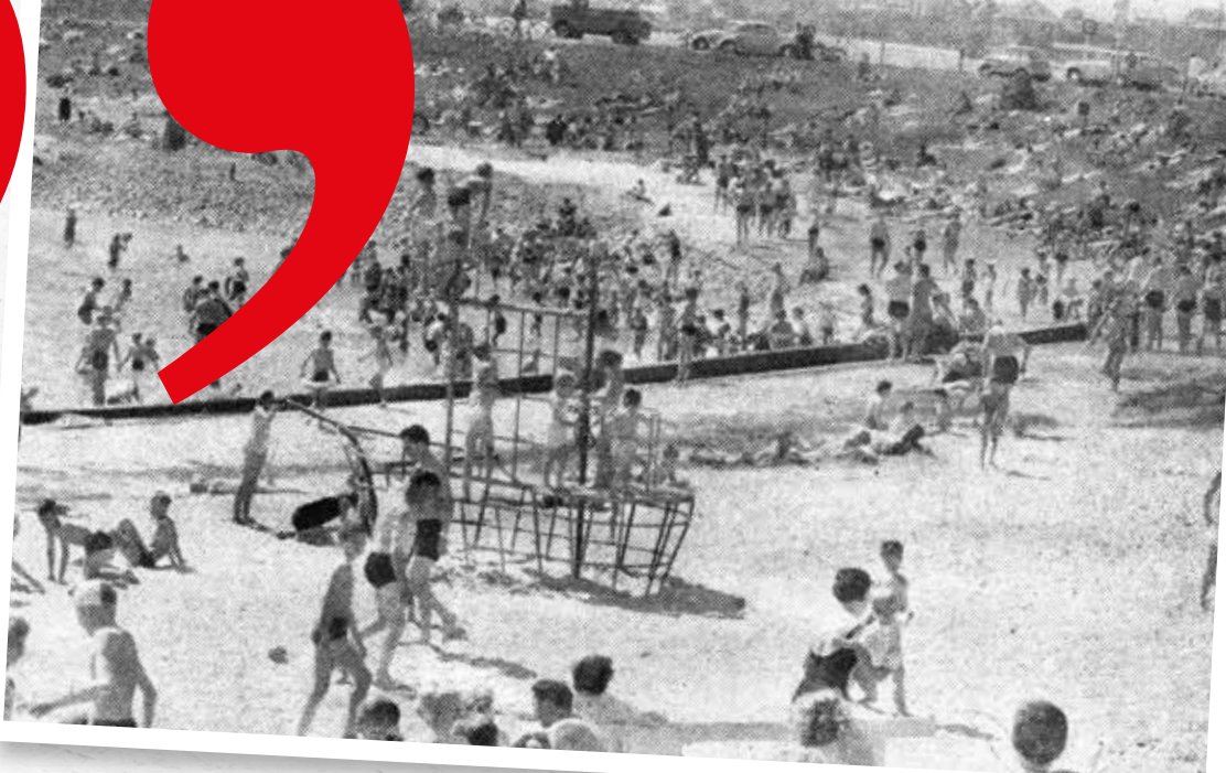
Hochbetrieb am Plansch- becken
