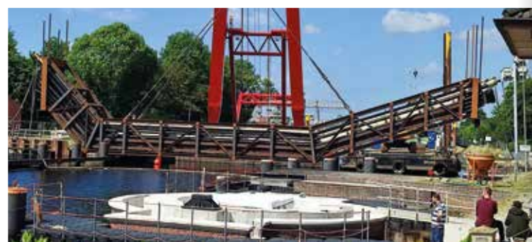
Absenken des Dükers im Kanal
