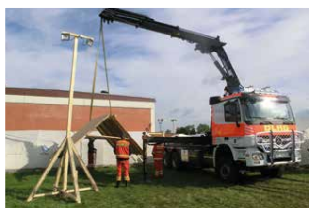
Aufbau einer Erstaufnahmeeinrichtung 2015
