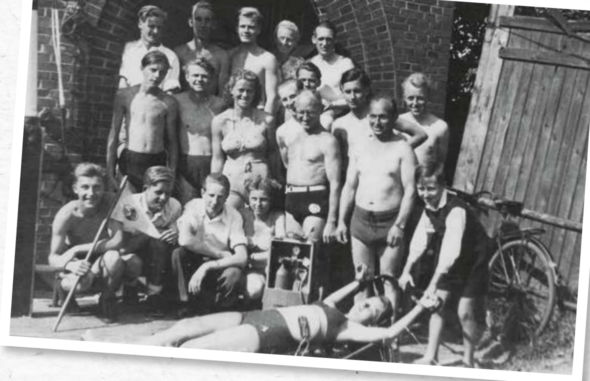
Die Wachmannschaft im Brückenwärterhaus an der KW-Brücke
