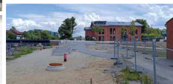
Vorbereitungen für die neue Zufahrt zum Vereinsheim
