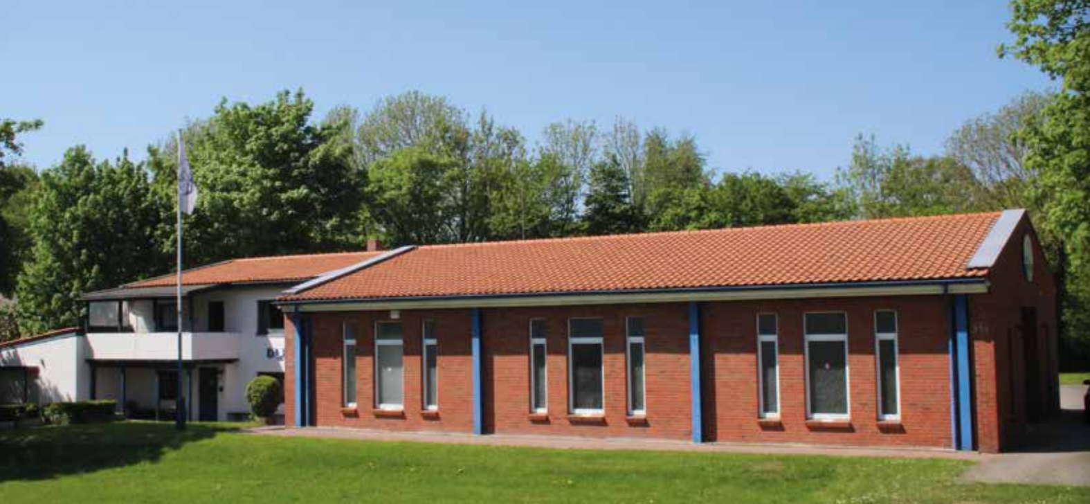
Blick auf die neue Fahrzeughalle
